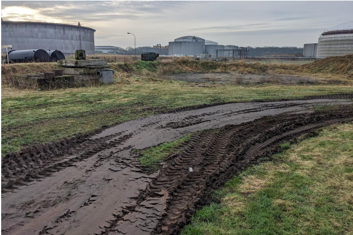
Südlicher Teilbereich der Vorhabenfläche mit dem versiegelten, ehemaligen Behälterstandort.
