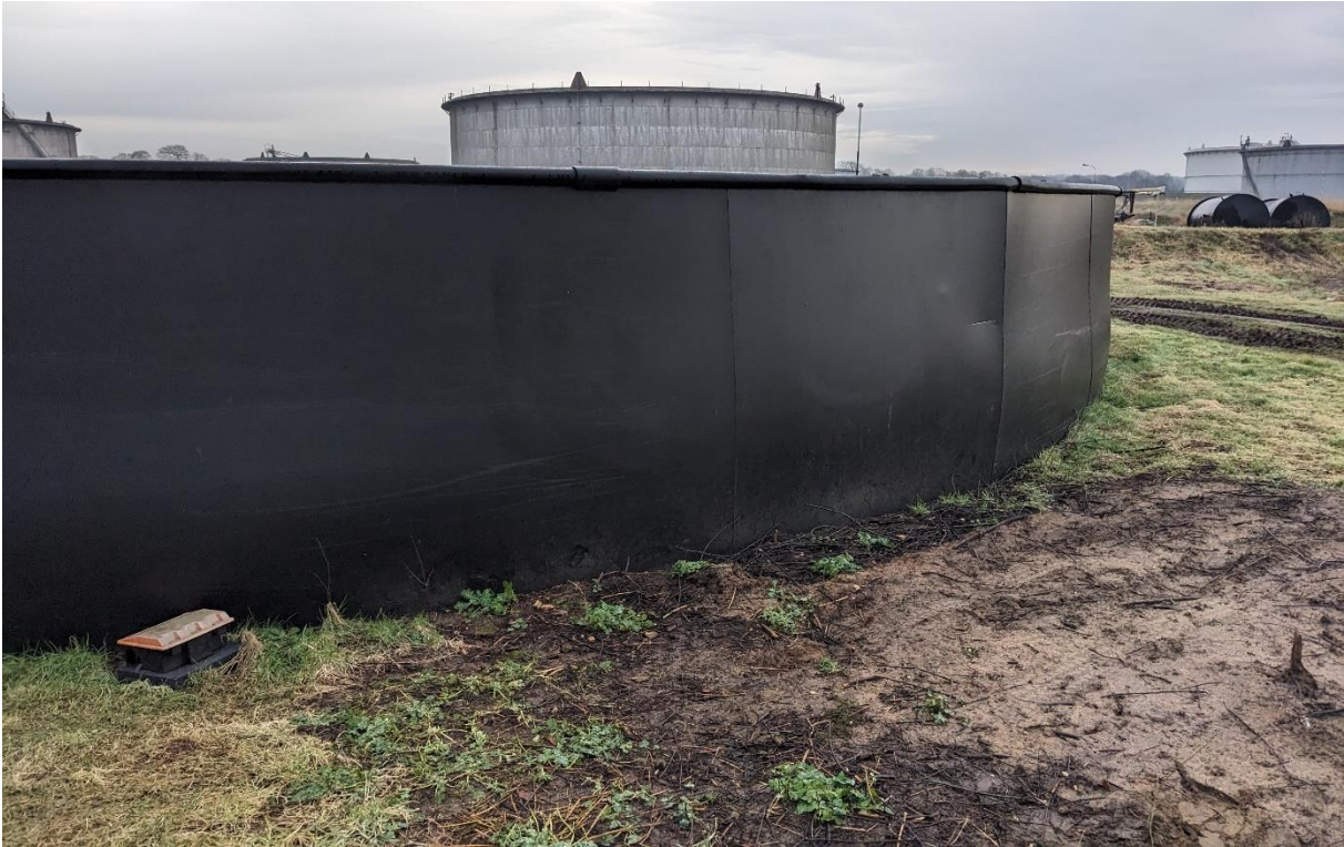
Der Behälter soll abgebrochen werden.
