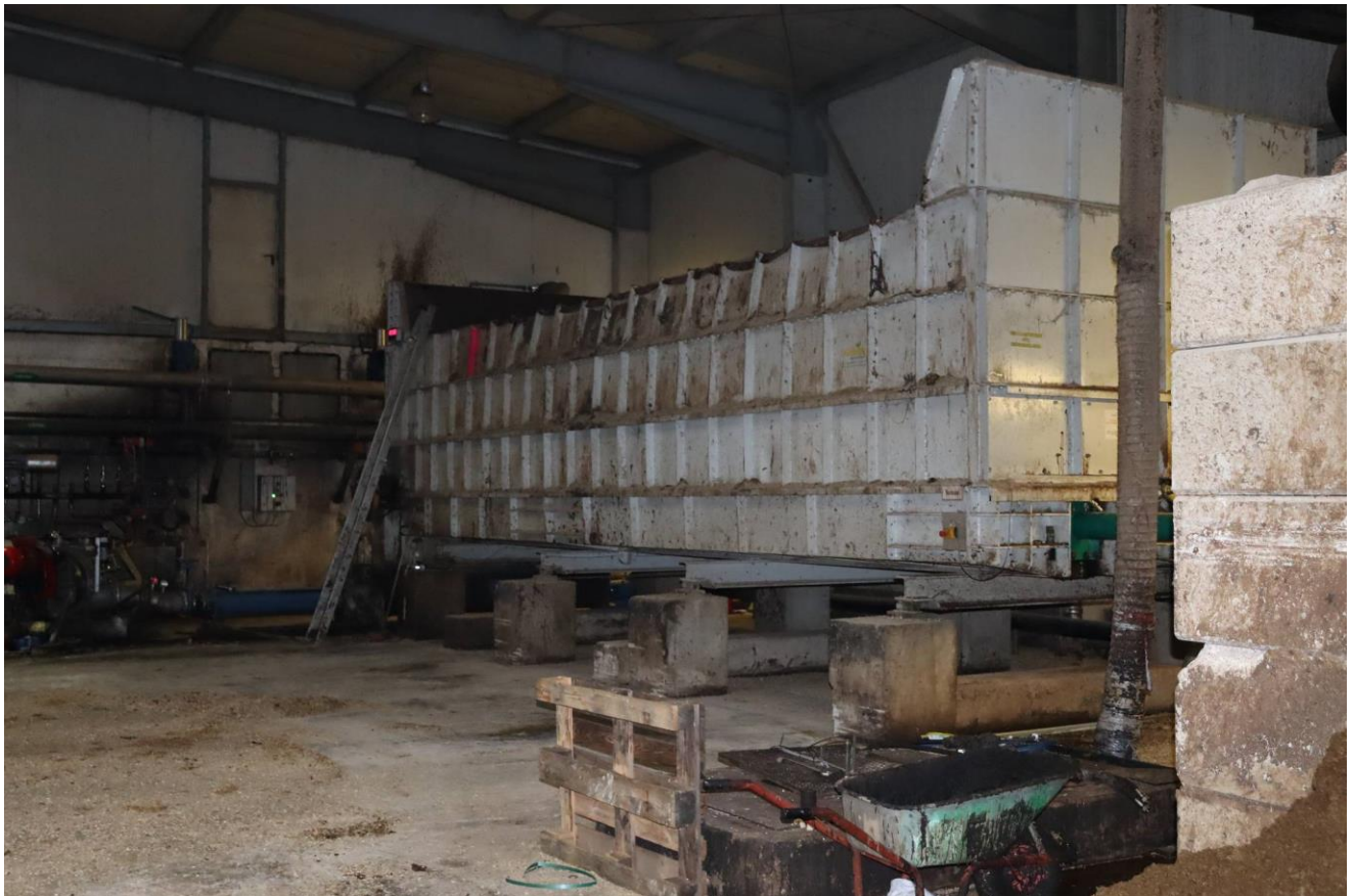
Aufgabenanlage in der Halle, Bioenergie Hünxe
