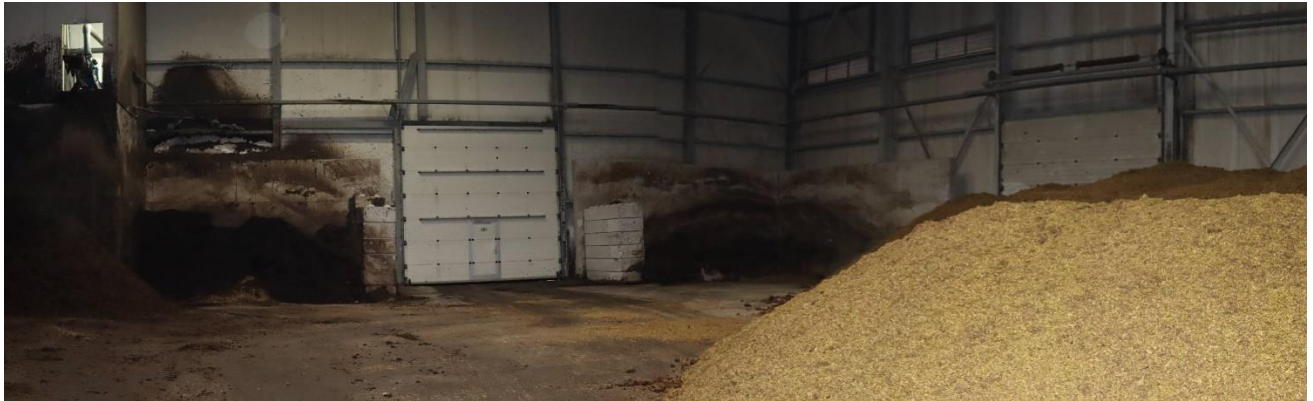
Einfahrtsbereich Anlieferungshalle Bioenergie Hünxe
