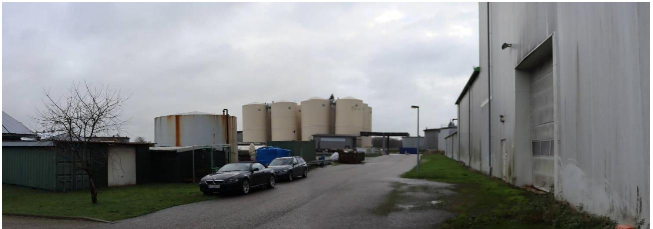
Blick in Richtung Osten: rechts Bioenergie Hünxe GmbH, links Nachbarbetrieb
