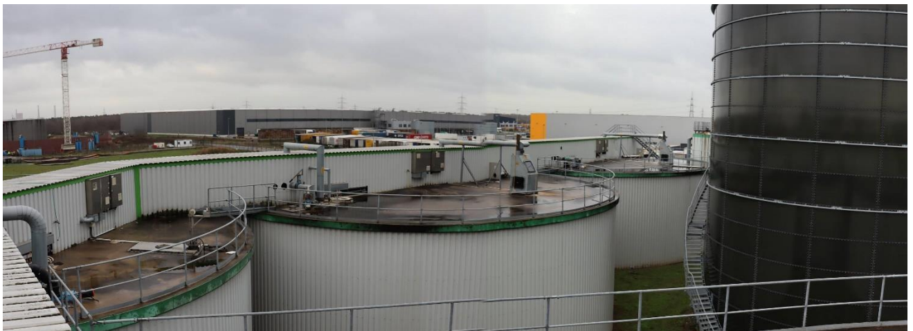
Blick in Richtung Südwest: Nachgärbehälter und Gärrestlager (rechts am Bildrand)
