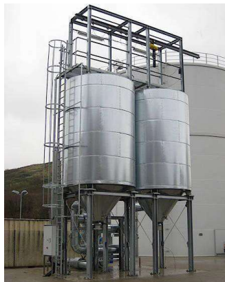
Bild 1 - Muster eines Doppelentschwefelungsmoduls
