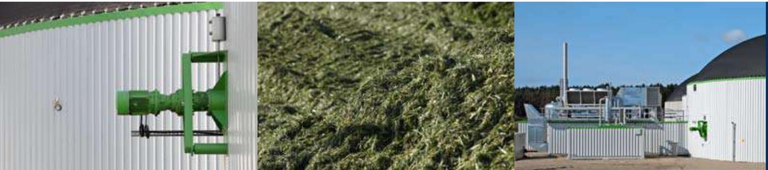
Im Zentrum jeder Biogasanlage steht der Fermenter mit seinem leistungsstarken und robusten Rührwerk. Das kontinuierlich laufende REMEX® Rührwerk dient zum Durchmischen von nachwachsenden Rohstoffen (NawaRos) und Gülle im Fermenter oder im Nachgärer der Biogasanlage.
