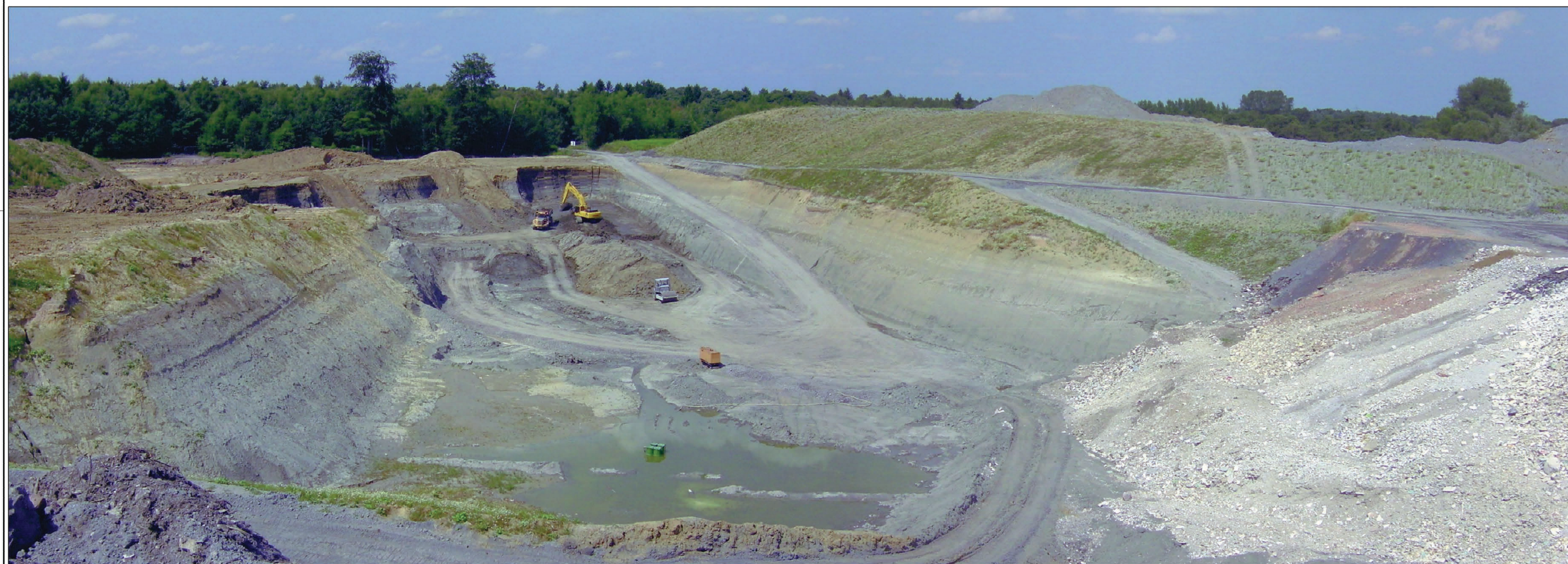
Foto 2: Blick aus Süden in Grube (Verfüllabschnitt 5)
