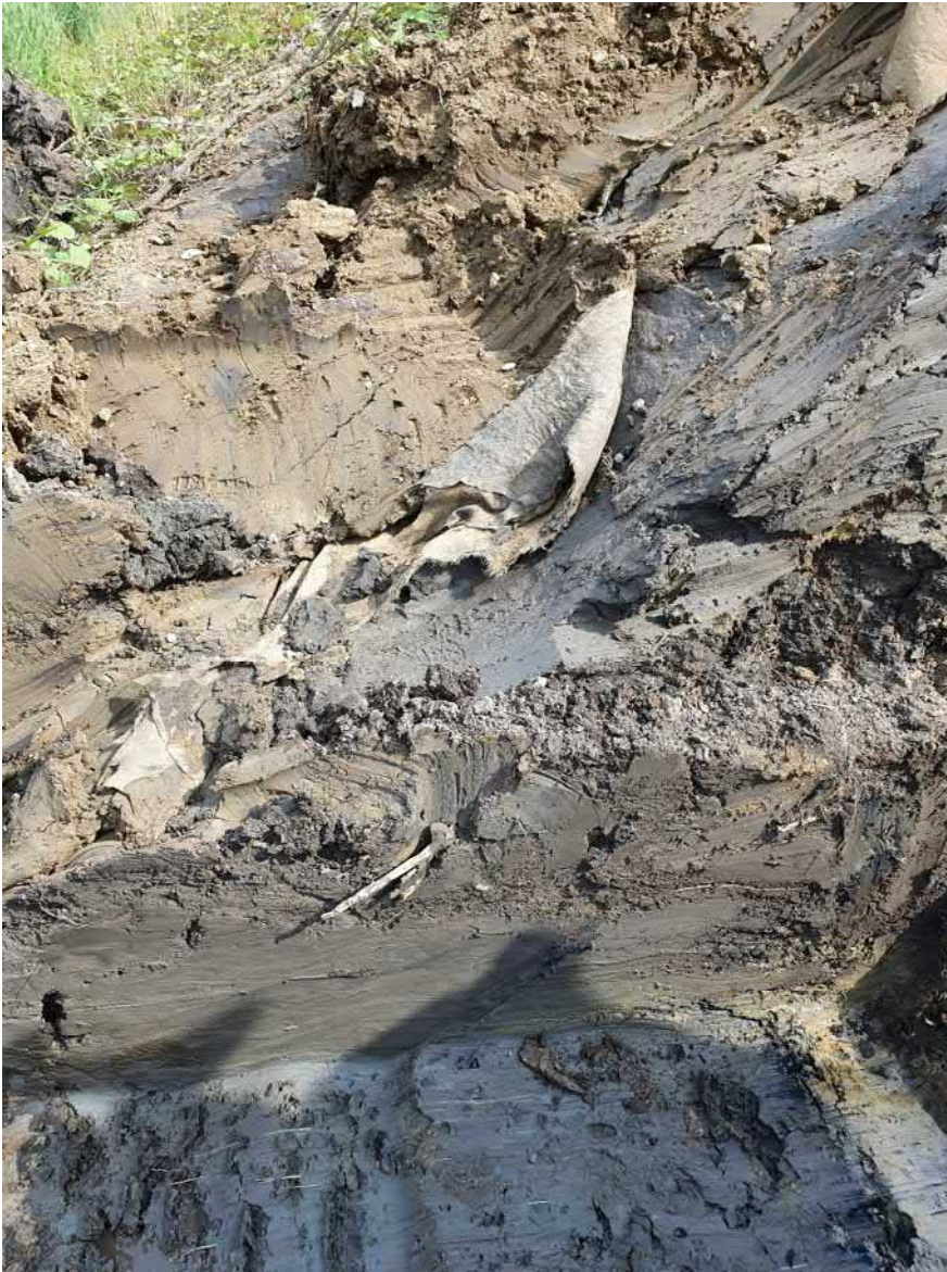
Abb. 4: Anbindung der mineralischen Dichtung an den Tonkeil
