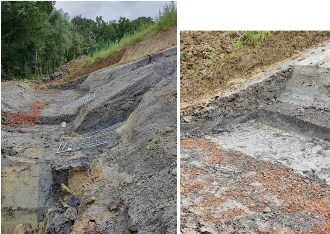
Abb. 2: Aufnahme Gesamtschurf; rechts Anbindung der mineralischen Dichtung (Oberflächenabdichtung) an den Tonkeil (südl. Ende des Schurfs)
