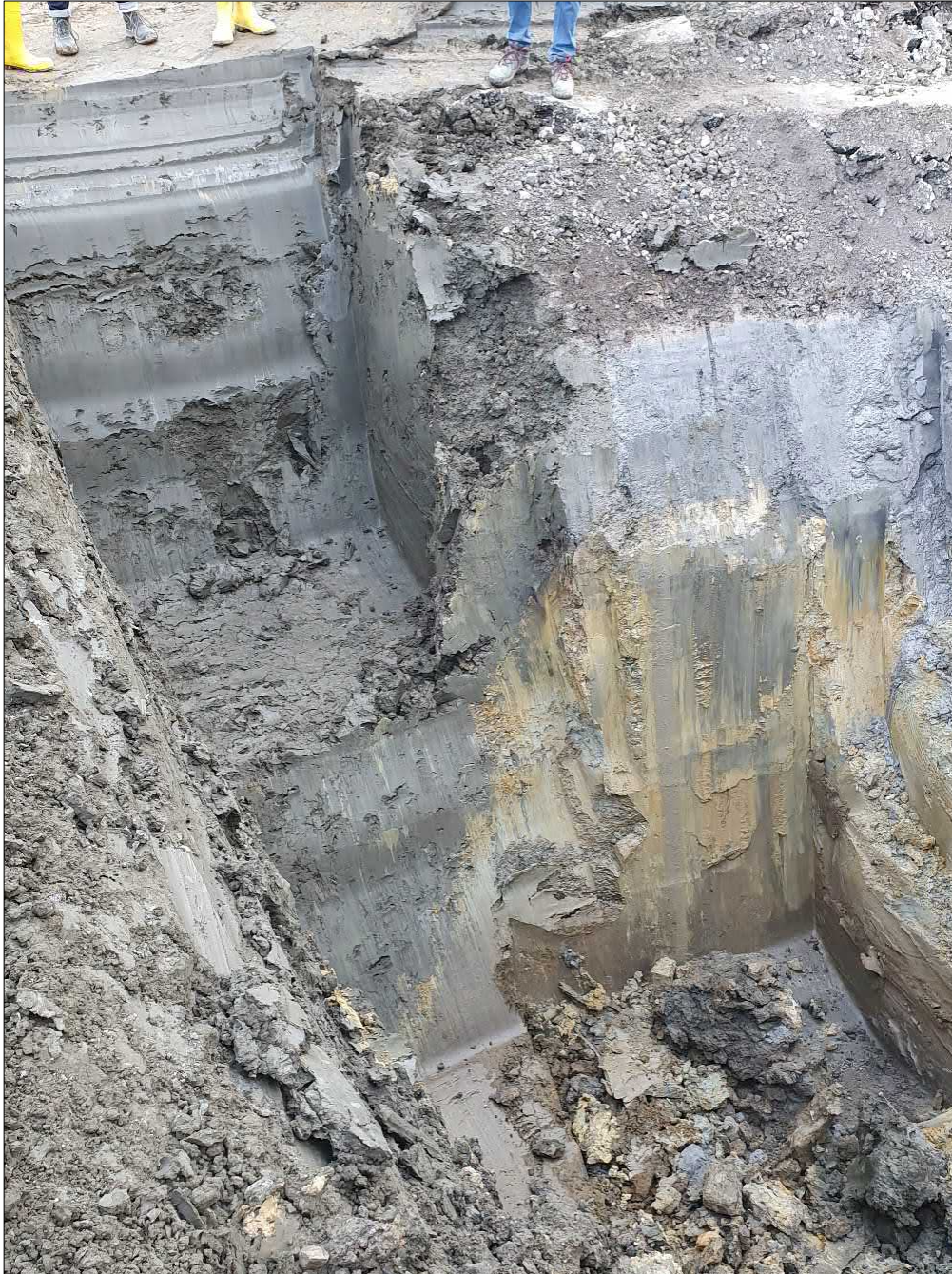
Abb. 7: Innenseite, Tonkeil und Anschluss an den Geschiebelehm / Lintforther Schichten
