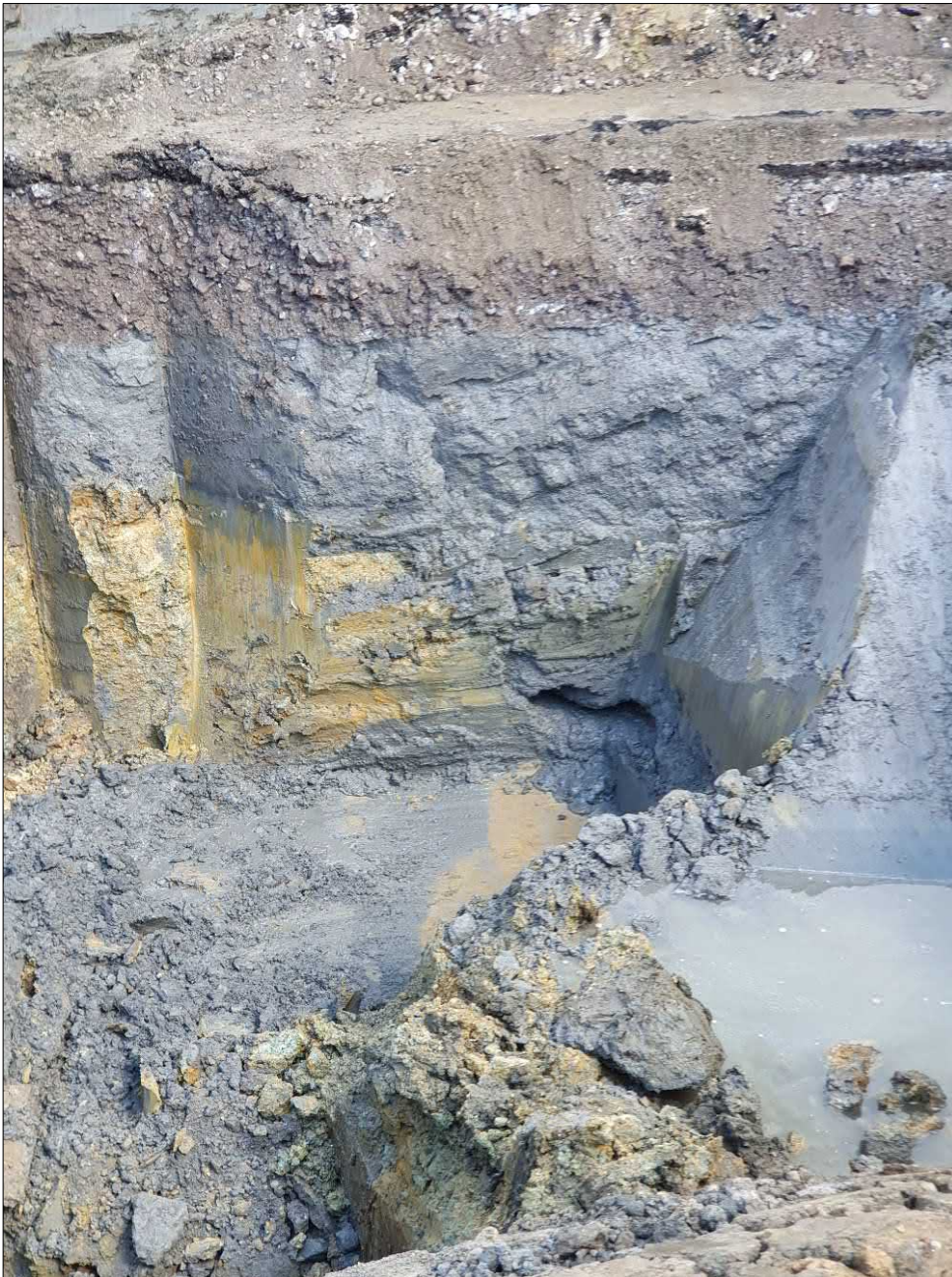
Abb. 8: Geschiebelehm, links wahrscheinlich anstehend, überlagert von Flugasche, rechts umgelagert mit einem Bereich von wassergesättigter Flugasche (Blick nach Norden)
