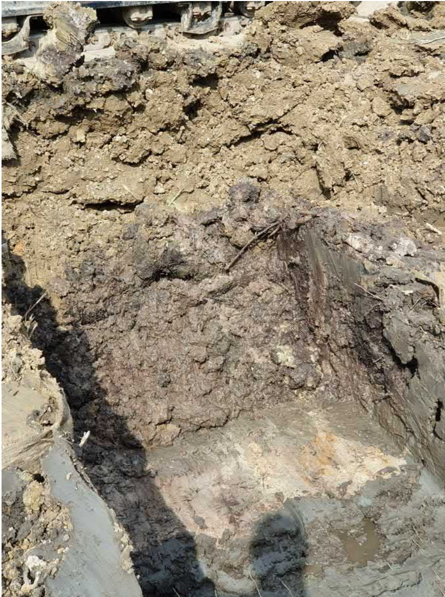
Abb. 5: Anstehender Boden westlich des Tonkeils (grabenseitig), Lehm, sandig z.T. stark humos – torfig; mit ausblutendem Wasser
