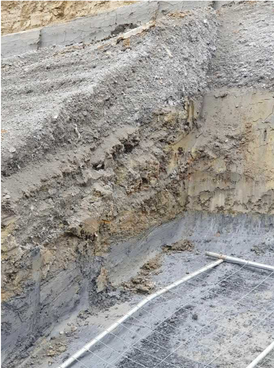
Abb. 6 zeigt in der Draufsicht die Abfolge der eingebauten Schichten in dem Querschlag Schurf 3b:
