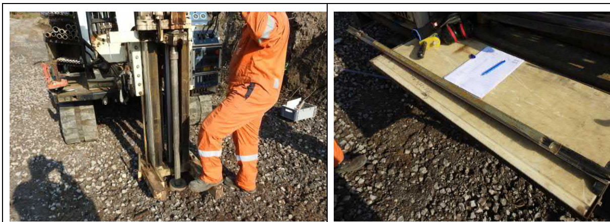
Abbildung 13 Sondiergerät mit Sondiergestänge (links) und Liner mit Bohrgut (rechts)
