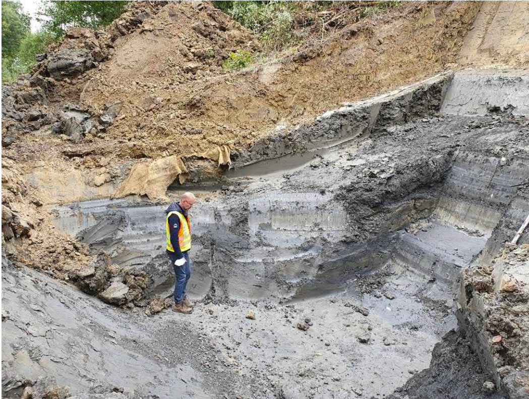
Abb. 4: Schurf 4 Südansicht: Anbindung der Oberflächenabdichtung an den Tonkeil
