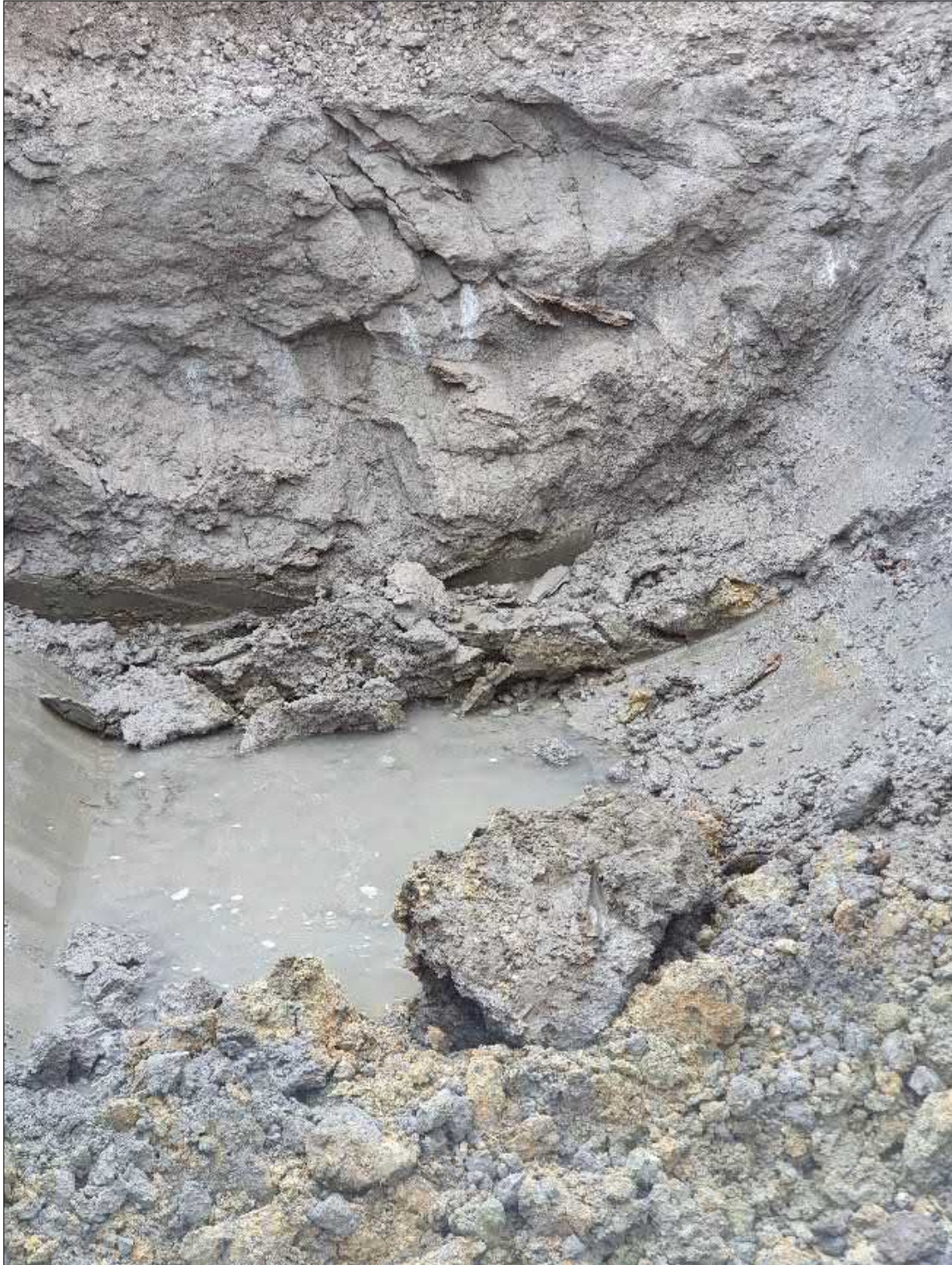
Abb. 5: Weitere Wasseraustritte in den Flugaschen (Ostseite des Schurfs 1)
