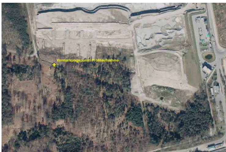
Abbildung 10 Vermarkungspunkt der Profilaufnahme der Grubenwand Tonabbau Eichenallee
