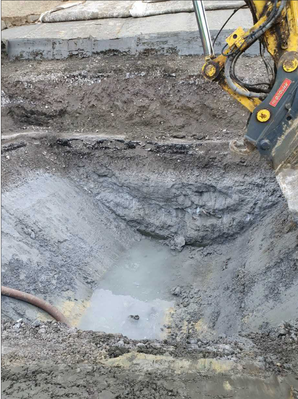
Abb. 2: Schurf 1 am 14.04.2021 morgens vor der Vertiefung, Blick nach Osten
